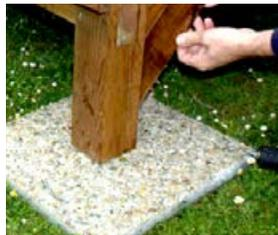
Positionné sur des dalles gravillonnées, le châssis du plancher est composé de lambourdes 95 x 45 mm et de traverses 120 x 45 mm.
