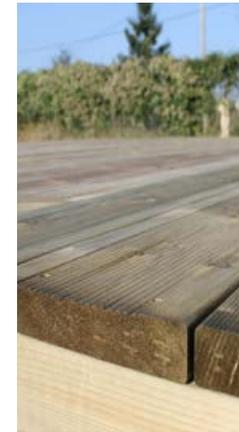
Des lames de terrasse prédécoupées de 27 x 145 mm pour un assemblage rapide et facile et un système d'isolation avec bâche sous plancher pour éviter les remontées de courant d'air froid en intérieur de la tente.
