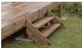
Positionné sur des dalles gravillonnées, le châssis du plancher est composé de lambourdes 95 x 45 mm et de traverses 120 x 45 mm. Option : kit d'ancrage.
