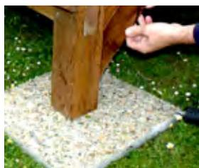
Colocado sobre **losas de gravilla**, el armazón del suelo está compuesto por rastreles de 95 x 45 mm y travesaños de 120 x 45 mm.
